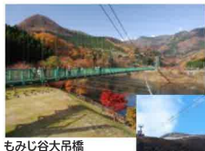
もみじ谷大吊橋
